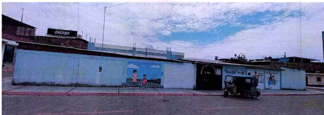
IMAGEN N° 03.- IMAGEN FRONTAL DEL TERRENO
