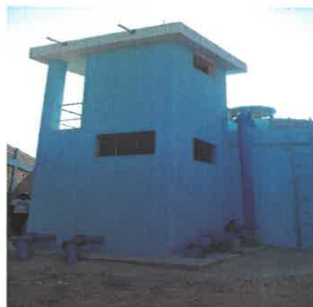
Reservorio apoyado de 250 m3, ubicado en la parte alta del CP Puerto Rico
