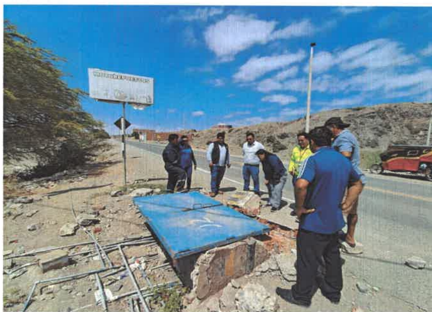
Plataforma de entrega de agua directo de la línea de conducción en plataforma, se aprecia las tuberías de PVC expuestas
