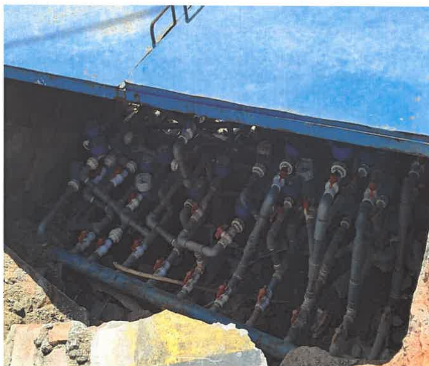
Plataforma de entrega de agua directo de la línea de conducción en plataforma, se aprecia la instalación de micromedidores de volumen.
